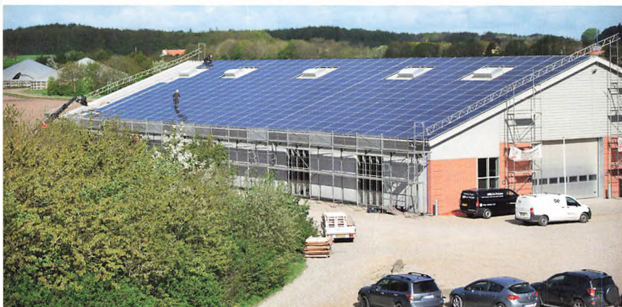
▲ I foråret blev der installeret solceller på maskinhallen.
