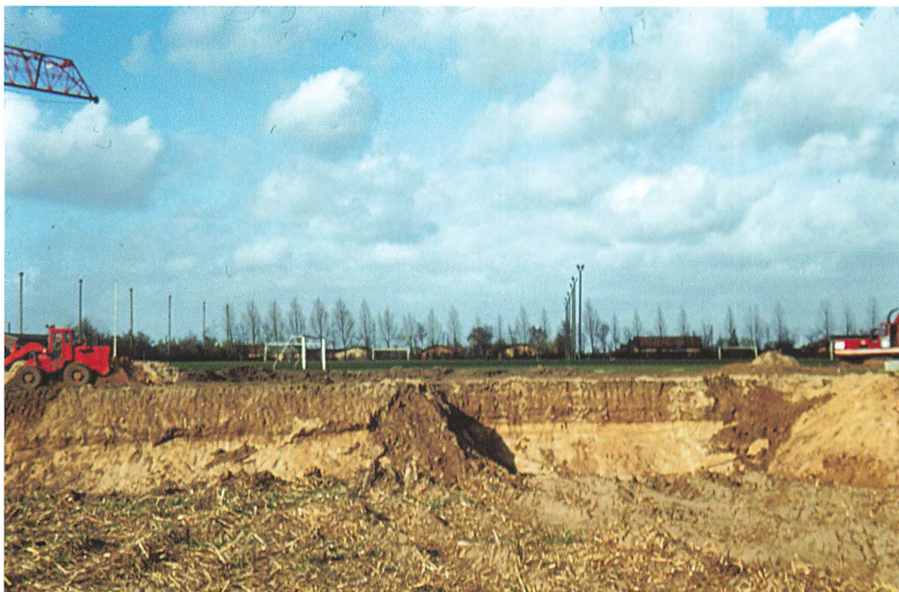
Grunden til det ny gymnasium under udgravning i foråret 1973. Under et lag moræneler på ca. 2 meters tykkelse kom man ned til smeltevandssand. Herved kunne et geologisk forhold anskueliggøres for eleverne (Hans Behrndt Andersen fot., Lokalthistorisk Arkiv).
