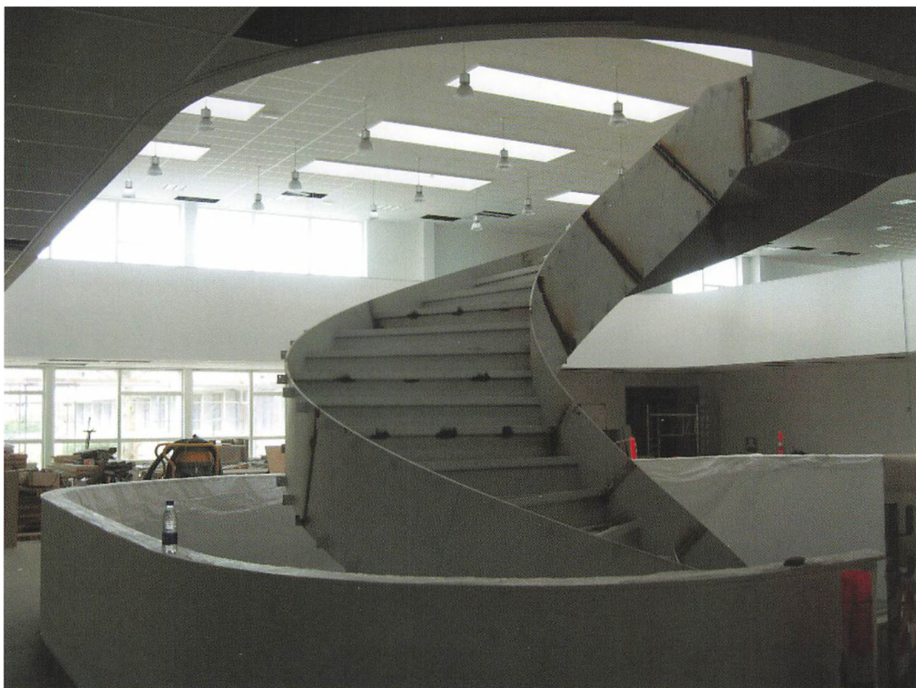
Ombygningen af Fredericia Gymnasium er tæt på at være tilendebragt. I april 2008 kunne man se den nye trappe mellem stueetagen og 1. sal tage form (Fot. Fredericia Gymnasium).
