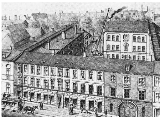
Hassel & Teudts Maskinfabrik i Bredgade o. 1888. Udstillingslokaler og kontorer er placeret i stuen mod Bredgade, mens den egentlige fabriksbygning er opført i gården. Firmaets specialiteter var vand- og gasanlæg samt apparater til brandbekæmpelse. N. Malmgren, Danmarks industrielle Etablissementer, I, 1888.
