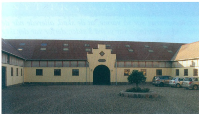
Avlsgården fra 1933 er tilpasset moderne landbrugs behov, så den kan stadig benyttes.
