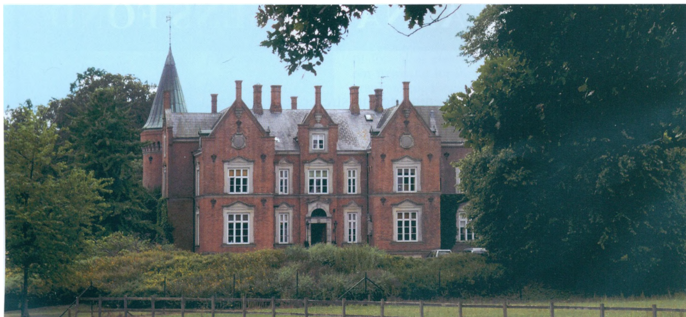
Hovedbygningen til Knuthenborg.
