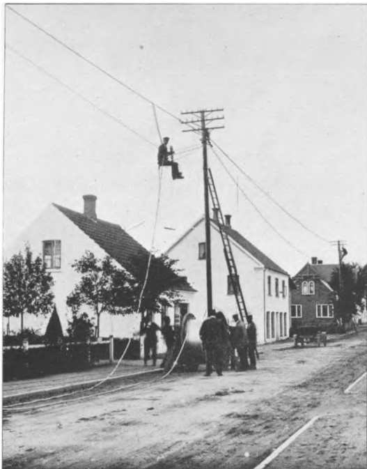
OPHÆNGNING AF ET LUFT-KABEL
