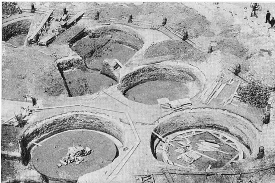
Udgravninger til Bunkers i Muslingeskallen foran Københavns Raadhus. De cirkelformede Udgravninger er færdige, og man er begyndt at bygge Trærammerne op til Støbning af Betonkuperne.
