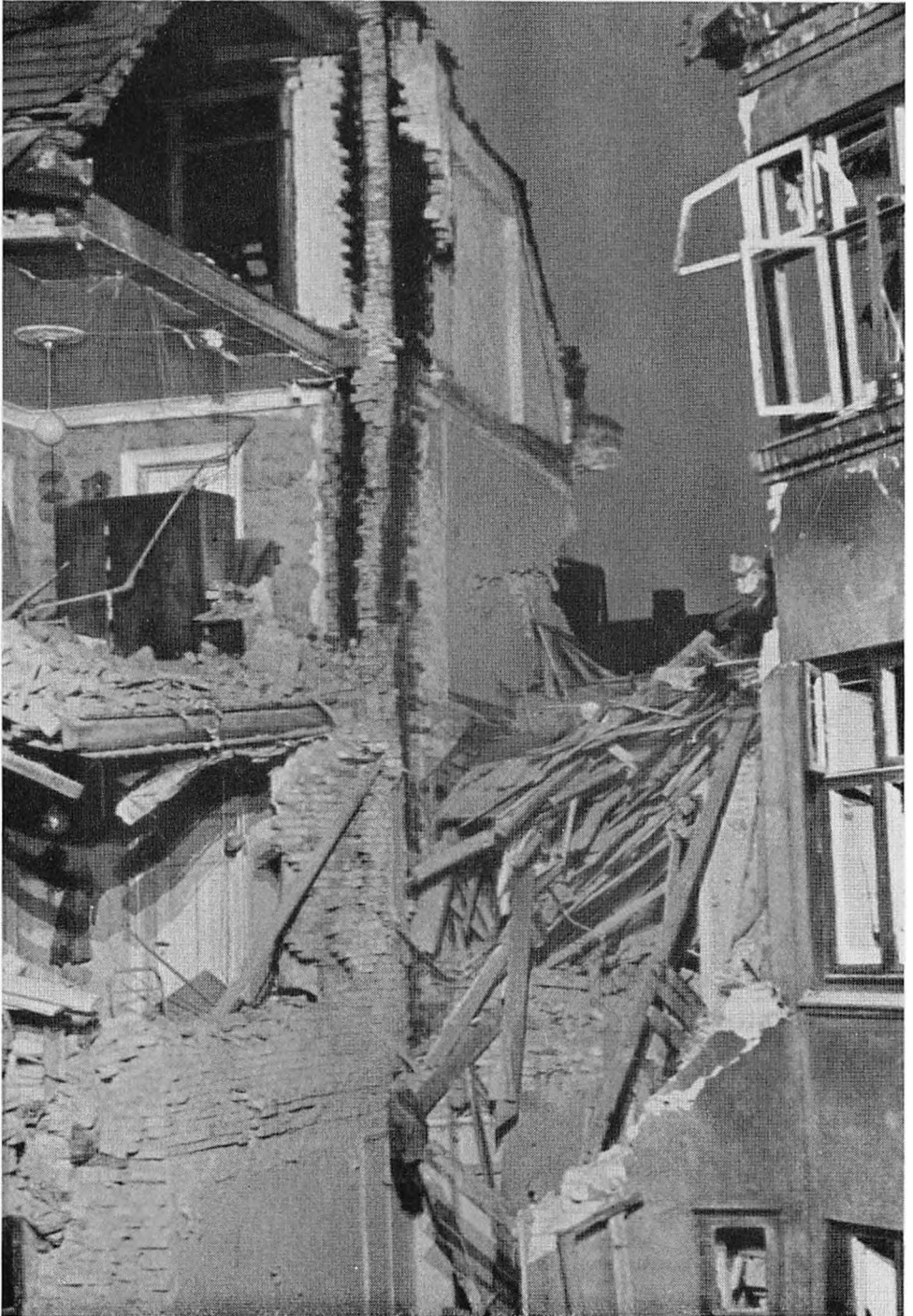
Ved Bombardementet af B. & W. blev enkelte Beboelseshuse i Islands Brygge-Kvarteret ramt. Her et ødelagt Hus i Gunløgsgade.
