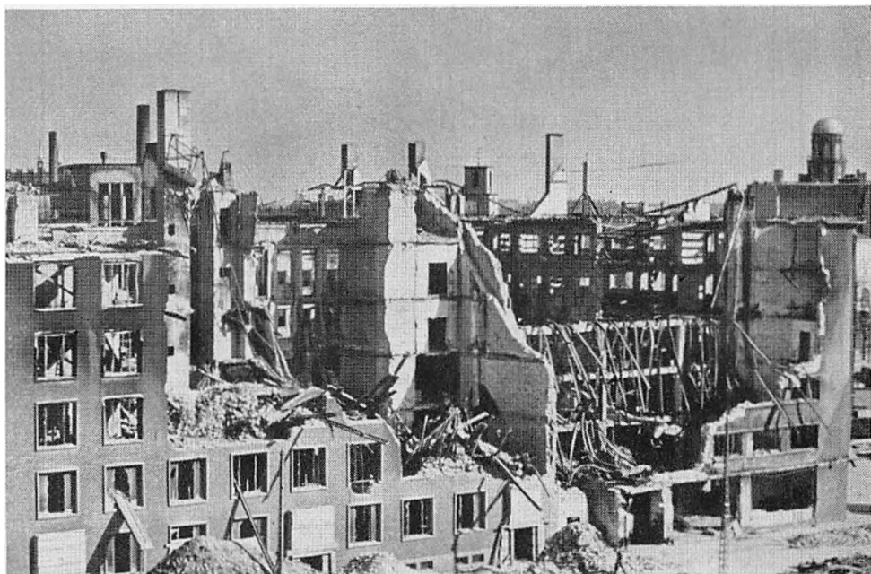
Efter 21. Marts 1945: Resterne af Shell-Huset og Arbejdsmændenes Bygning efter de engelske Maskiners Præcisionsbombardement.
