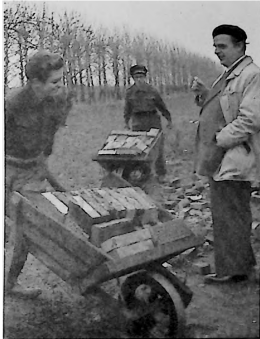
Der køres mursten til nyt svinchus på træningsskolen
