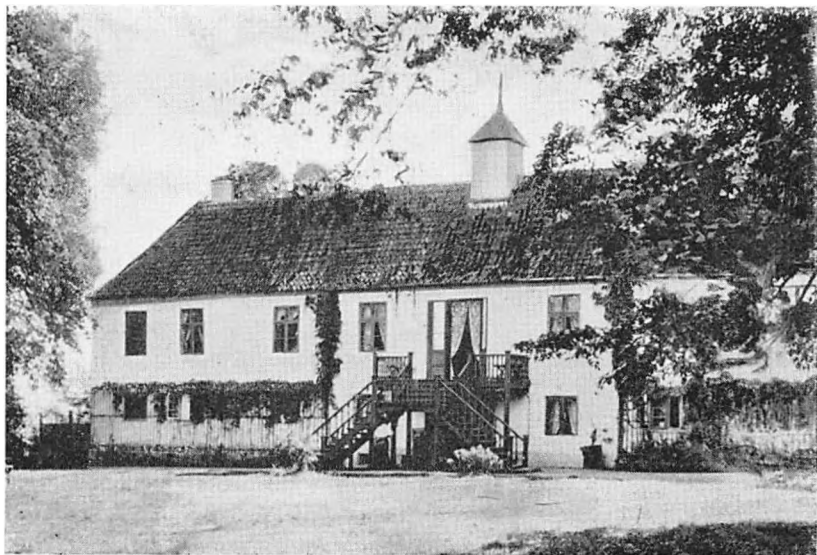
Rungstedgård da den var pensionat. Bygningen var efterhånden meget forfalden og blev revet ned i 1917. En ny bygning, placeret lidt nordvestligere end den gamle, blev opført i de følgende år. Den huser nu Forsikringshøjskolen. - Postkort, ca. 1910. Museet.
