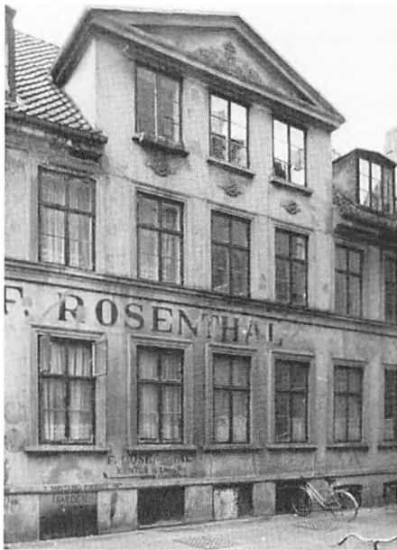
Mellemhuset Vesterbrogade 124. (Huset nedrevet).
