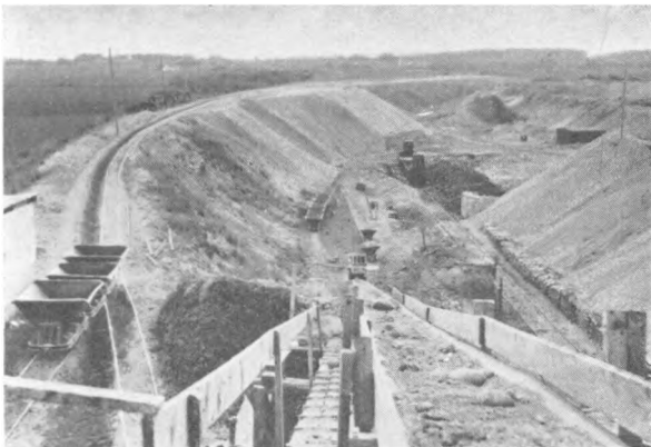
Transportbaandet, der fører Stenmaterialerne fra Graven til Maskineriet.
