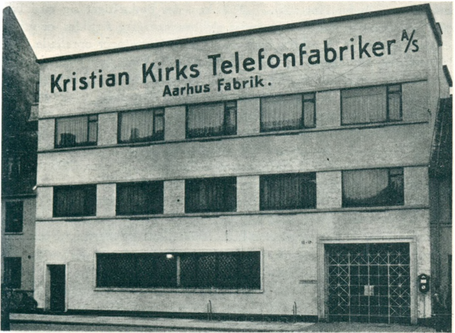
Aarhus Fabrikens Kontorbygning.
