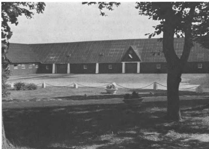
Laden i baggrunden er over 100 år. Murene er endnu snorlige trods det de er muret op med ler.
