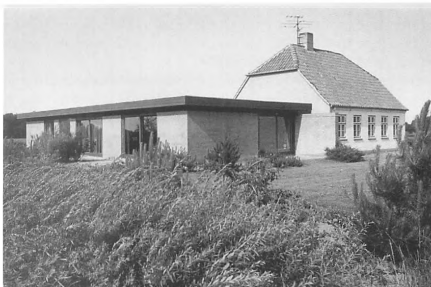
Mange af de husmandssteder, hvor produktionen blev nedlagt, opkøbtes af folk fra byen og indrettedes af dem til en rummelig bolig med gode hobbyarealer. På dette eksempel fra Rønhavekolonien har en tilbygning i moderne byggestil erstattet den oprindelige stald. Gunnar Solvang fot.
