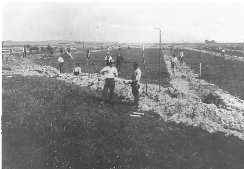
I den preussiske tid vandt rørdræningen stærkt frem på geesten. Her lægges der drænrør på Ganderupgårds marker ved Fole i 1912. Fot. i Historiske Samlinger.
