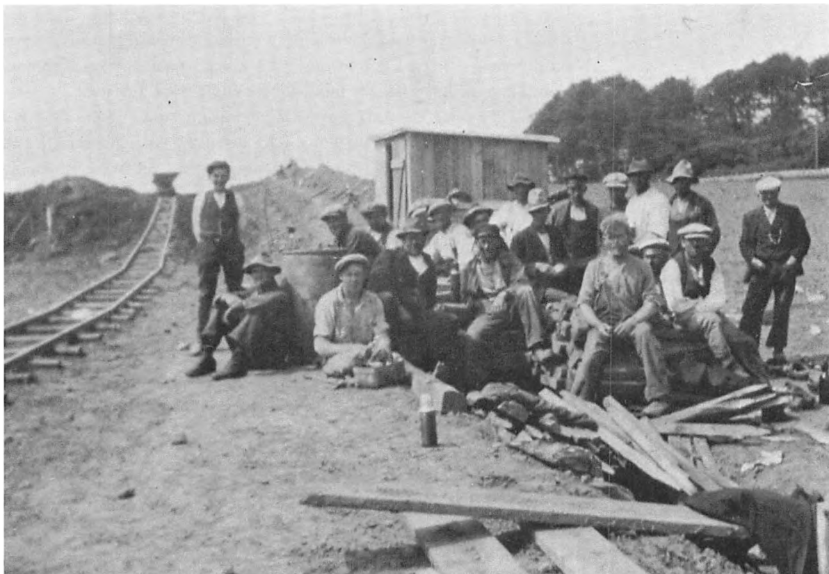
En pause i arbejdet ved anlægget af Vestvejen under Besættelsen. (Foto Hist. Samlinger)
