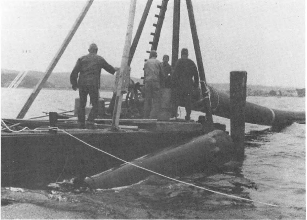
Aftøbsledningen fra rensningsanlægget nedsænkes i fjorden. (Foto Hist. Samlinger)
