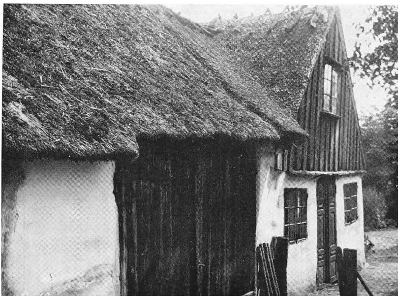
Det sydvestlige hjørne af Hans Christian Petersens gård med udkørslen fra vestlængen til toften. I gavlen ses indgangen til øverste stue. I forgrunden to stolper af et rækværk, der adskilte toften og haven. Foto 1929. Nationalmuseet.
