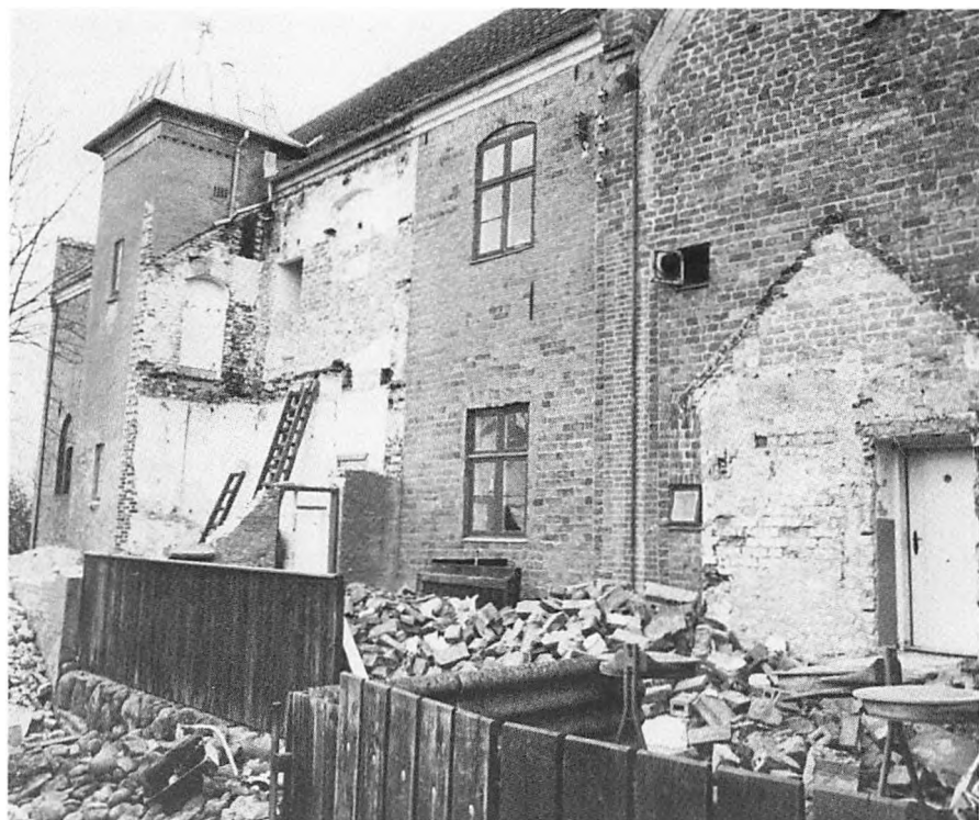
Her på nordsiden af Hospitalet lå de skumle dårekister. Senere kom der forskellige andre tilbygninger, som alle forsvandt ved den store restaurering i 1975-76. Her: kaos og jammerlighed. Lokalthistorisk Arkiv, Viborg.
