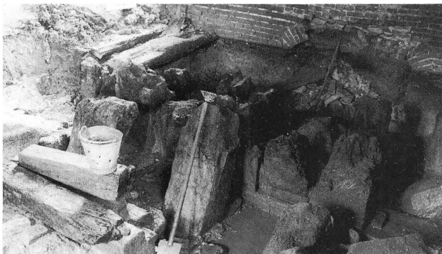
Murbuen fra Chr. IV mølle samt de gamle egefundamenter for hammerværket. Foto: Svend Engelbrechtsen 1964.
