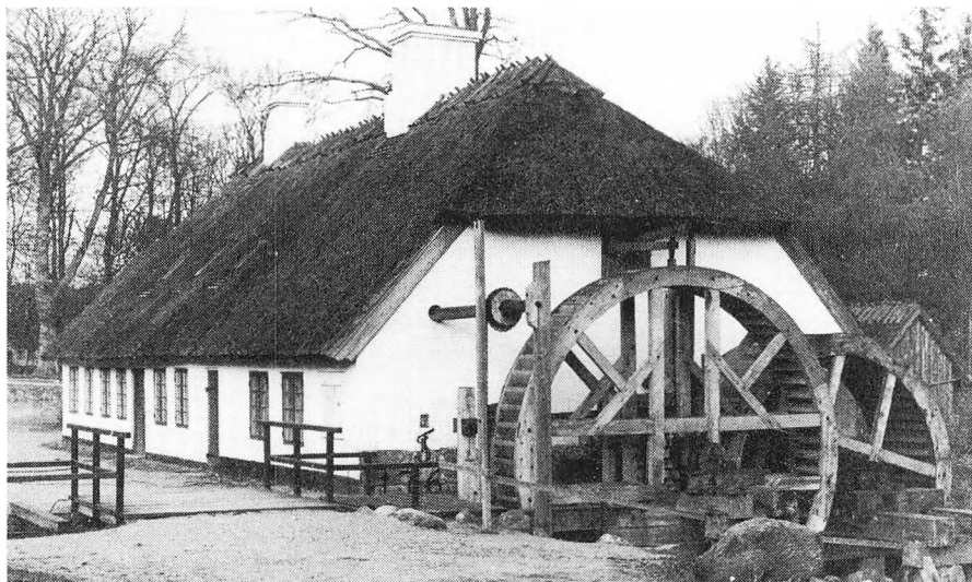
Møllen set fra sydøst. Døren og de to nærmeste vinduer hører til hammerværkstedet. I gavlen ses Fr. 5.s navnetræk og årstallet 1765. Broen fører over malekarmen, der lukkes af stignordene. Foto: Svend Engelbrechtsen.
