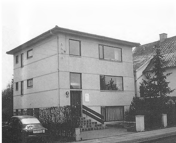
Carl Plougs Vej 57 er opført i 1937. Huset er et godt eksempel på et type 4 hus, der med sin pudsede mur, de vandrette bånd og det flade tag har fået bungalowudstyr.
