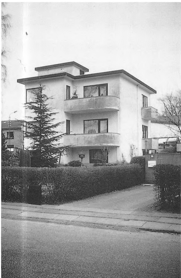
Krathusvej 1, »Corner« opført i 1935 er et andet eksempel på den internationale funktionalisme.
