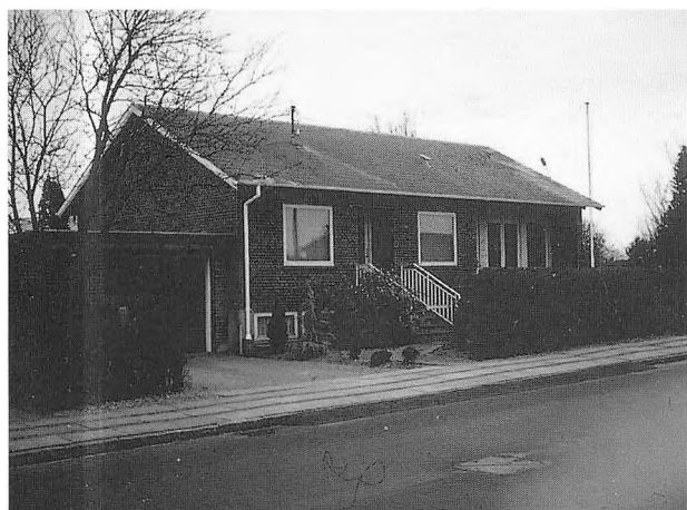
Et længehus opført i røde mursten og med eternittag. Det 96 m 2 store hus er tegnet af O. Jensen og opført i 1957. Carl Plougs Vej 83.
