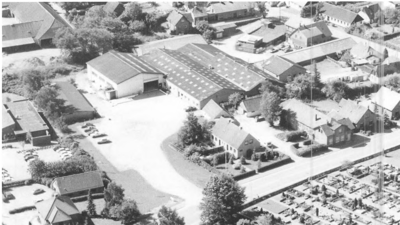
Den 1. marts 1979 kunne Fiberline flytte i lejede lokaler på Nr. Bjertvej 88, hvor en del af bygningerne stadig var lejet ud til andre virksomheder. Luftfotoet er fra midten af 1980'erne, hvor det gamle, nu nedrevne, mejeri og senere maskinfabrik på Rytterskolevej stadig ses. Yderst til venstre ses Lisberg Marketing.
