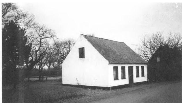
Rytterskolevej 26. Foto fra 1997.
