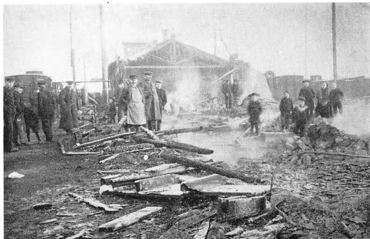
Den nedbrændte stationsbygning.
