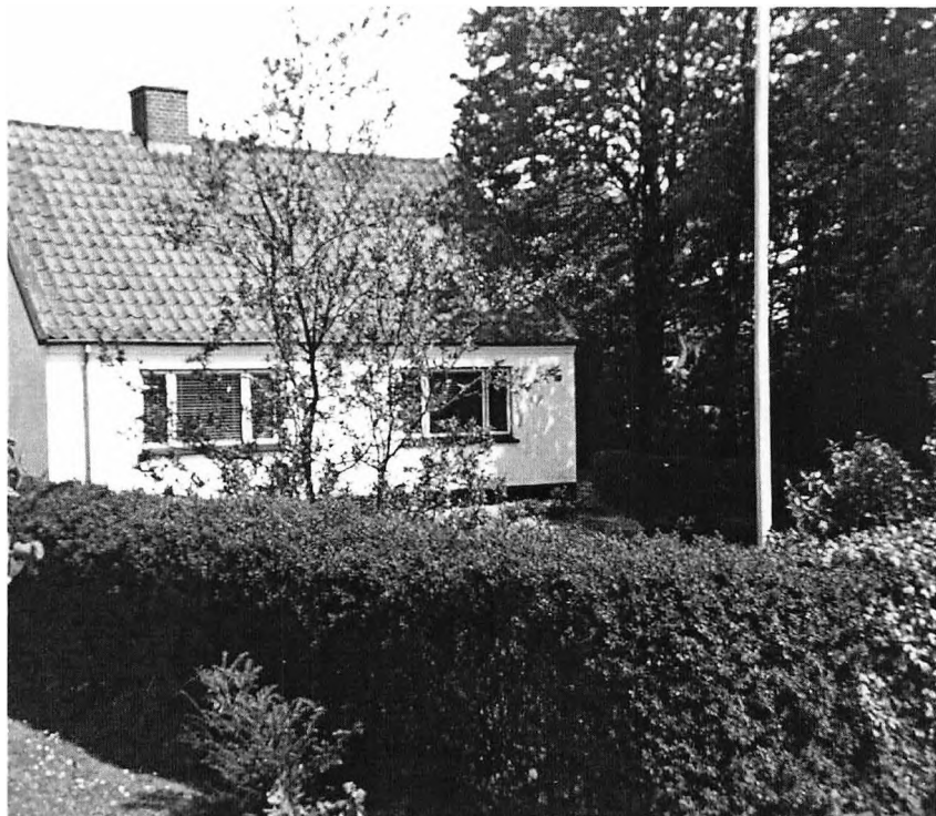
1963 Vores allerførste hus, landarbejderboligen i Høng
