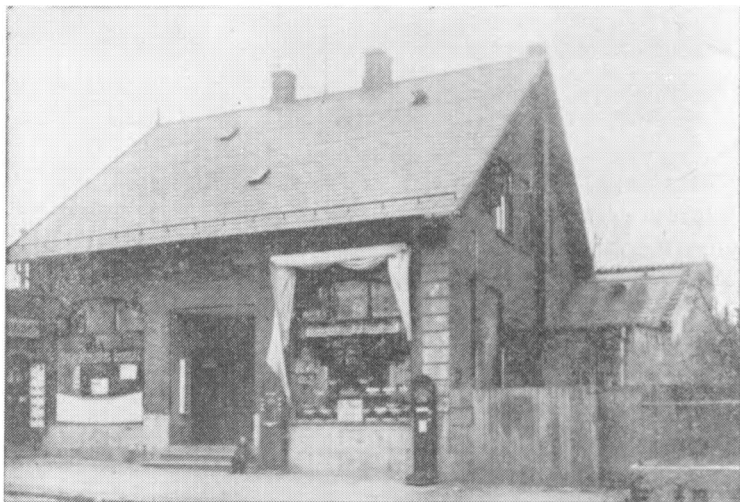
Ulrich Bergos Forretning.
