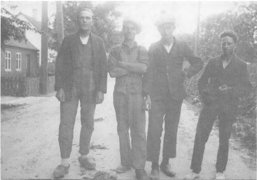
Fra venstre: Hakon Petersen, Ølbyvej 151, Viggo Larsen, Ølbyvej 160, Karl Hartmann, Krogstoftevej, Karl Christensen, Ølbyvej 140 - Ølby ca. 1925 (Ølbyvej 157 ses til venstre) - set fra syd
