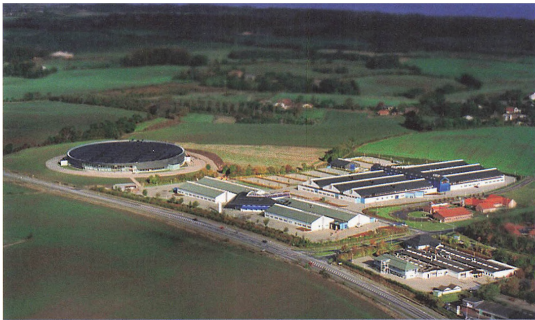
LINAKs hovedkvarter i Guderup i dag. Nederst i højre hjørne ses de oprindelige bygninger fra 1982
