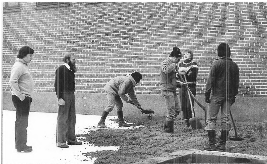
Der bygges opholdsstue
