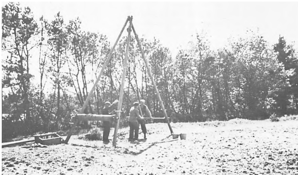
Fig. 33: Brunkulseftersøgningsboring, maj 1942. (DGU/KM).
