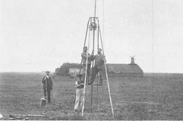
Fig. 88: Boring ved undersøgelse af Mejlby-gårdens mergelleje ved Rindum. (DGU/VM 1909).
