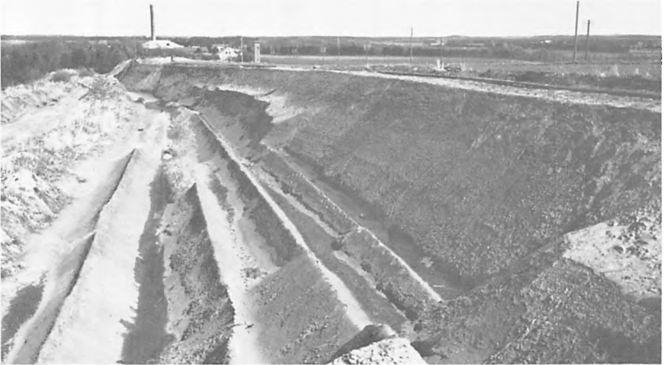
Fig. 14: Møltrup teglværksgrav øst for Tim kirke, i baggrunden teglværket set fra vest. Østlige del af en 200 m lang, 8-9 m høj gravvæg i mørk-gråt Gram-ler (marin Miocæn), overlejret af ca. 2 m moræneler. (DGU/CW – maj 1962).
