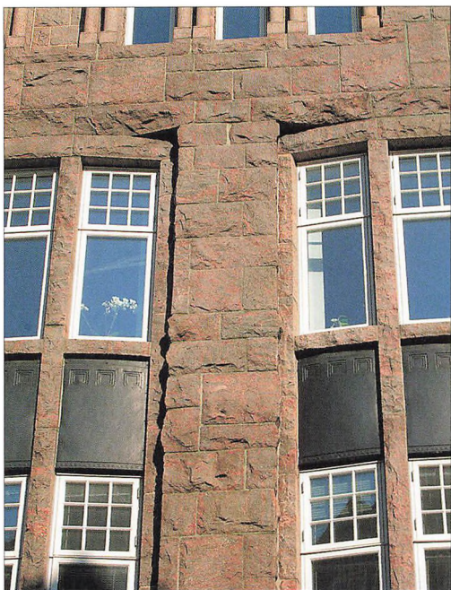
Den tidligere »Sonderburger Bank«, Perlegade 26 er i sin helhed et eksempel på den kejserlige nationalromantik, i slægt med Knivsberg-tårnet. I vinduesbrystningerne af kobber ses Jugendstilen stadig
