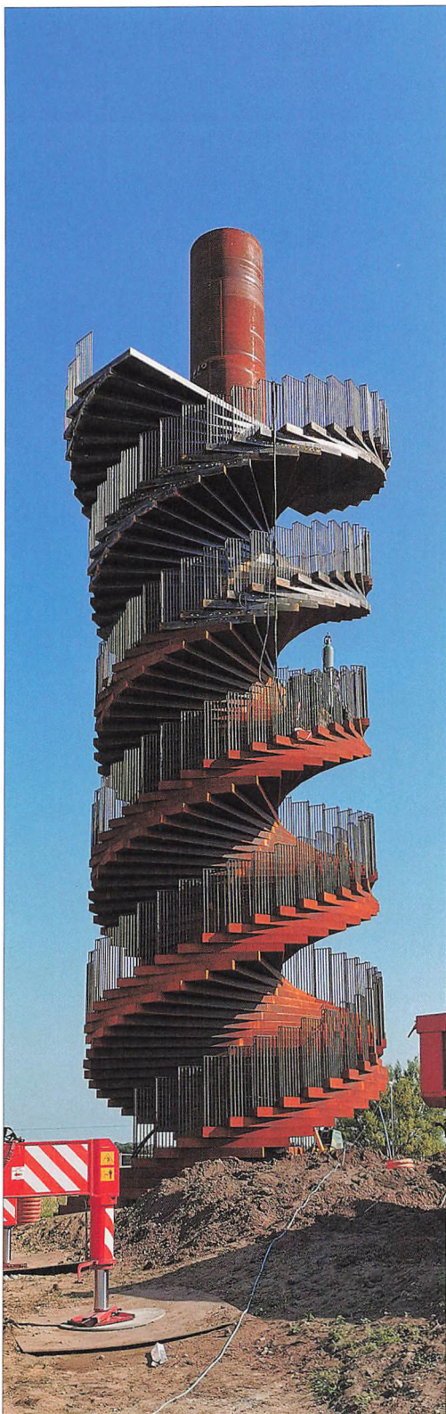
Marsk Tower under opførelse (foto: Mette Berg).
