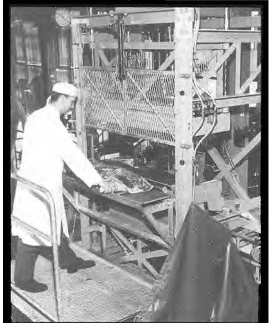
Udviklingsarbejdet af baconsprøjtemaskinen strakte sig fra midten af 1960'erne til ind i 1970'erne. Sprøjtenålenes placering — man endte med særskilte maskiner til højre- og venstresider, saltlagens dosering i de enkelte nåle og maskineriets driftssikkerhed med fugt og salt som de mest nedbrydende faktorer gjorde udviklingsarbejdet overordentlig vanskeligt. Billedet viser en af de første baconsprøjtemaskiner under afprøvning på Slagteriernes Forskningsinstitut omkring 1971.
