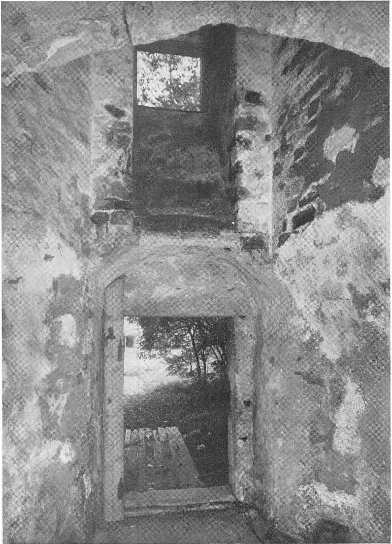
TAVLE 19. Oprindelig Kanonport i Flagbastionens søndre Flanke med Aftrækskanal for Krudtrøg over Porthvælvet.
