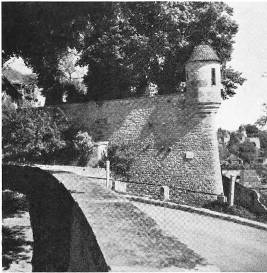
Fig. 8. Bastion de la petite Porte, Avallon, 1590
