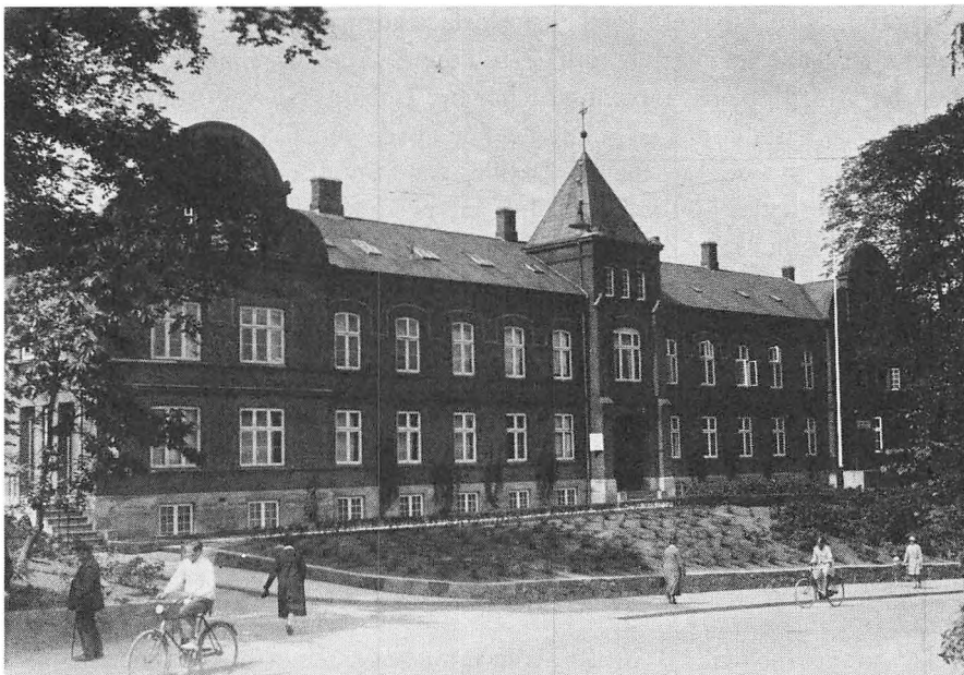
Der findes meget få tidlige fotografier af Århus kommunes fattiggård. Her er et billede fra 1920'erne af den i årene 1869–70 opførte bygning. I sommeren 1974 er fattiggården nedrevet. Det nye forsorgshjem er placeret i Østerby i Tranbjerg.
