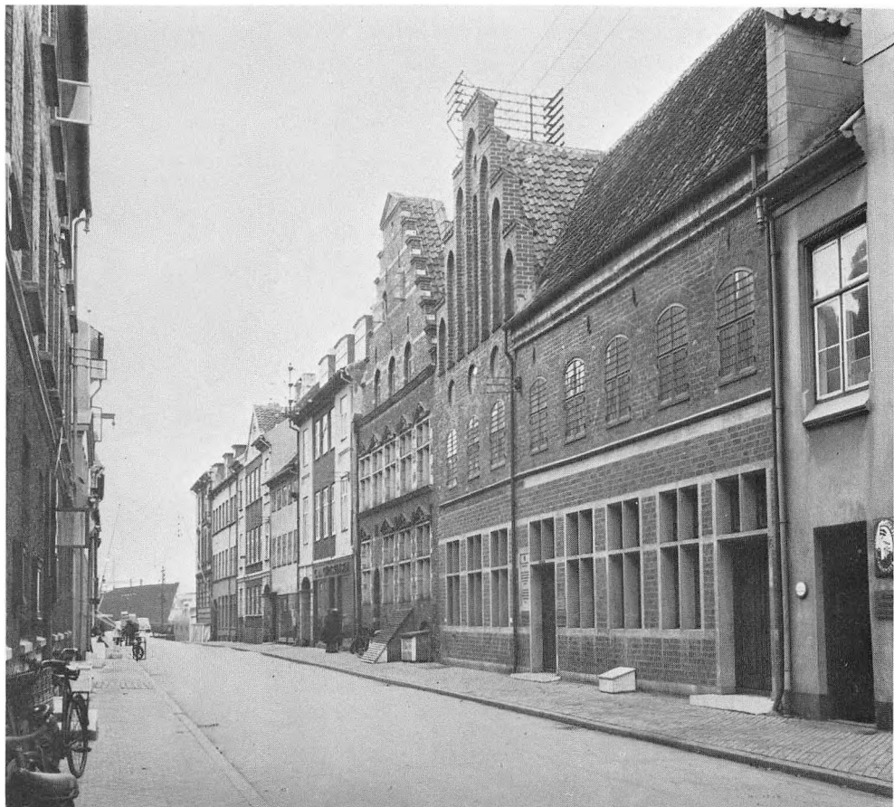
Sundtoldskarrens facader til Stengade. Til højre ses Dommergården og Tolder David Hansens Gård efter restaureringen. (fol. H.M. 1940).
