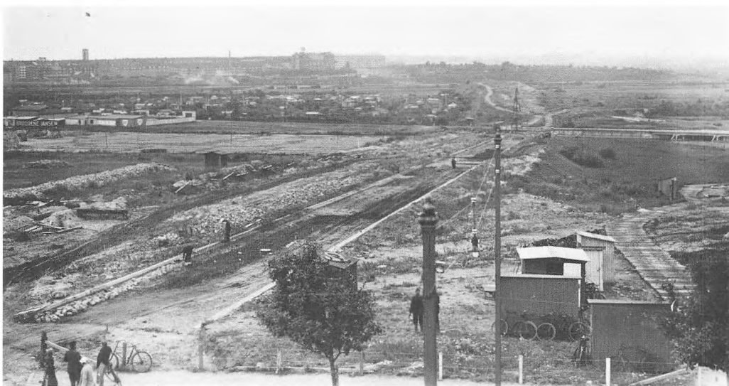
Ringgadeanlægget ved sommertide 1936. Fotografen har stået ved Silkeborgvej. Midt i billedet ses Søren Frichs Vej med broen over åen, lidt længere ude er rampen til broen under opfyldning. Læssøesgades Skole anes midt i baggrunden.
