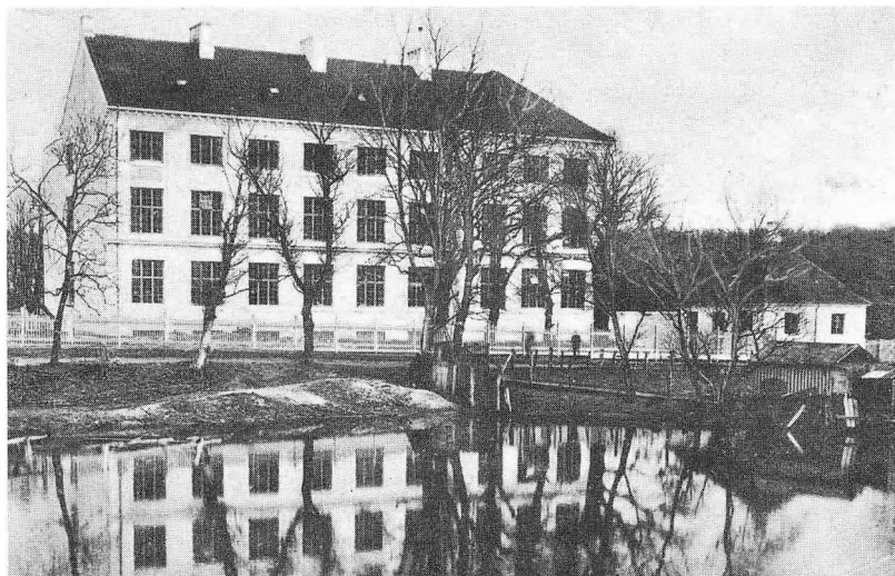
Marselisborg skole set fra Birketinget 1904; bygningen opført samme år
