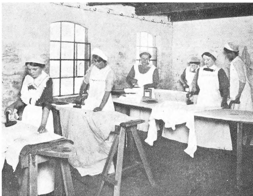
Fra strygestuen på Åbygård, øjensynlig i en tidligere staldbygning
