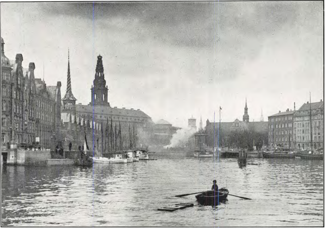
Indsejling til Slotsholmskanalen.
