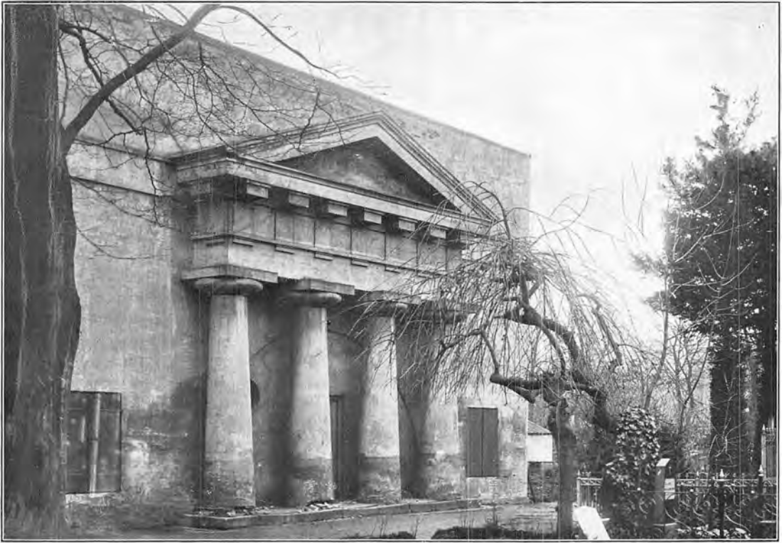
Jens Bang: Den tidligere Graverbolig paa Assistens Kirkegaard. Opført 1806—1808.
