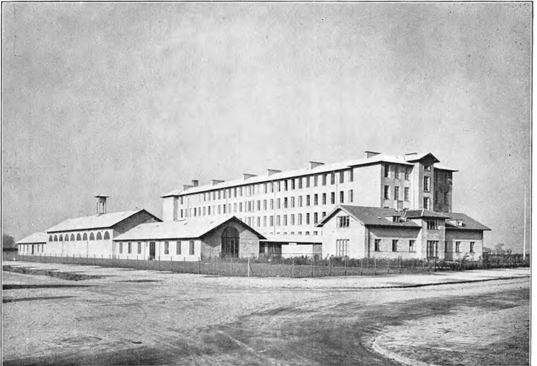
Kai Gulløb: Højdevangens Skole. Opført 1930.
