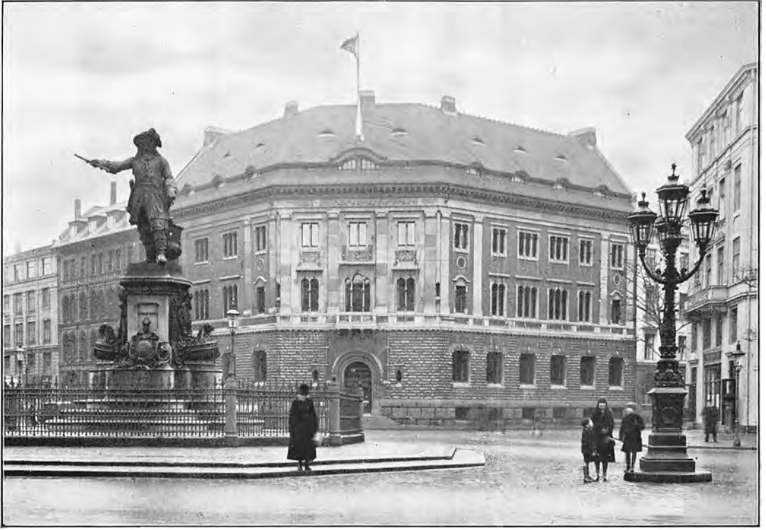
Gølfred Tvede: Østasiatisk Kompagnis Kontorbygning. Opført 1908.
