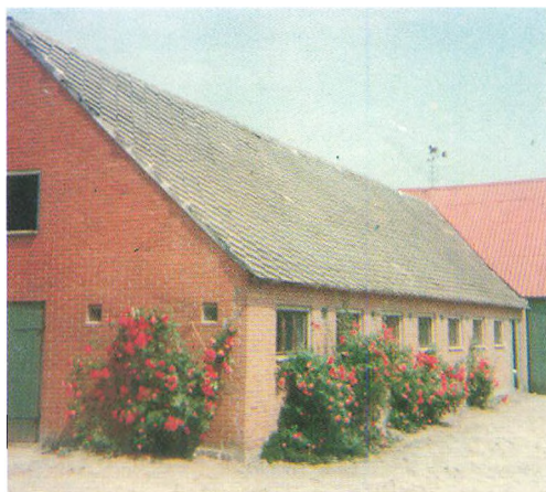
Gårdlængen. Ny væg 1959. Bagside 1960.
