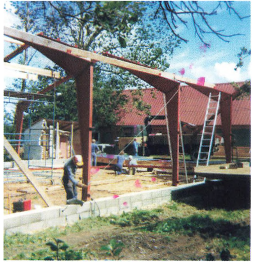
Maskinhuset under opførelse.
