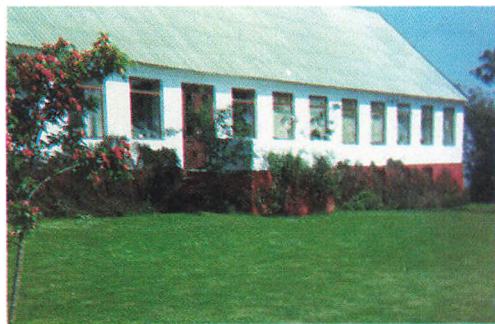
Det nye eternittag på stuehuset. Vestgavlen blev fornyet senere.
