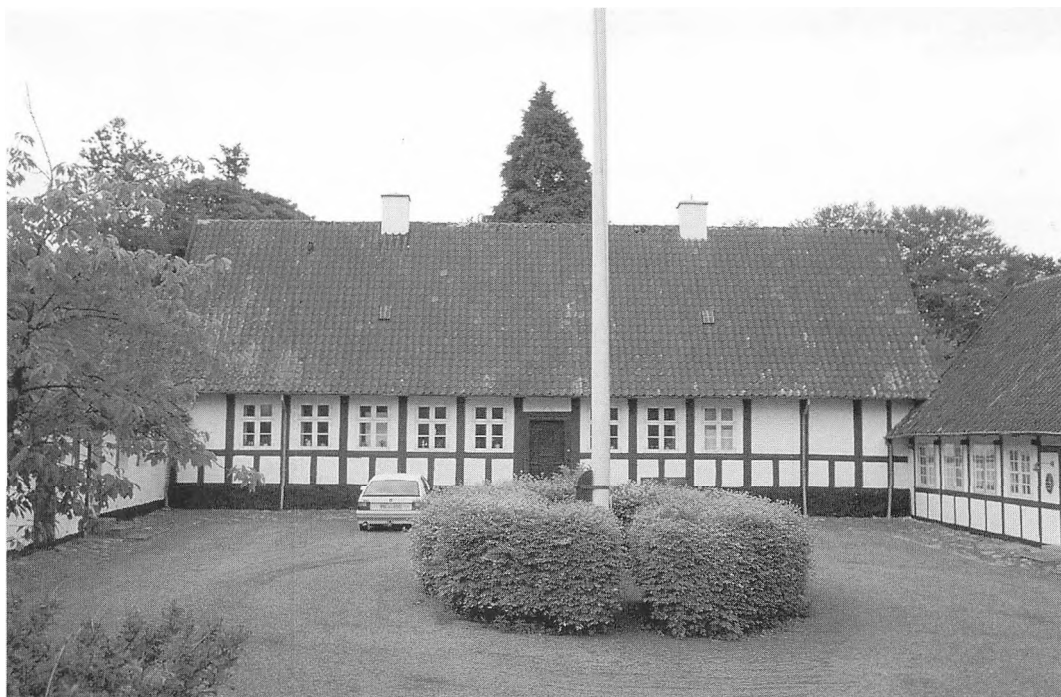
Fig. 2. Stuehusets facade til gården. Læg mærke til, hvordan tagfladen mødes med sidefløjens tag til højre i billedet. Det er et af tegnene på, at stuehuset er forlænget.
