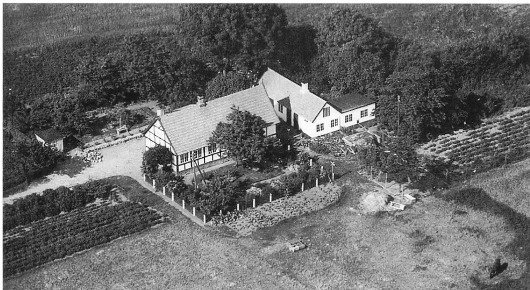
Fig. 14. Haregade 21, der blev landbørnehave og nu er ved at blive bygget om.
