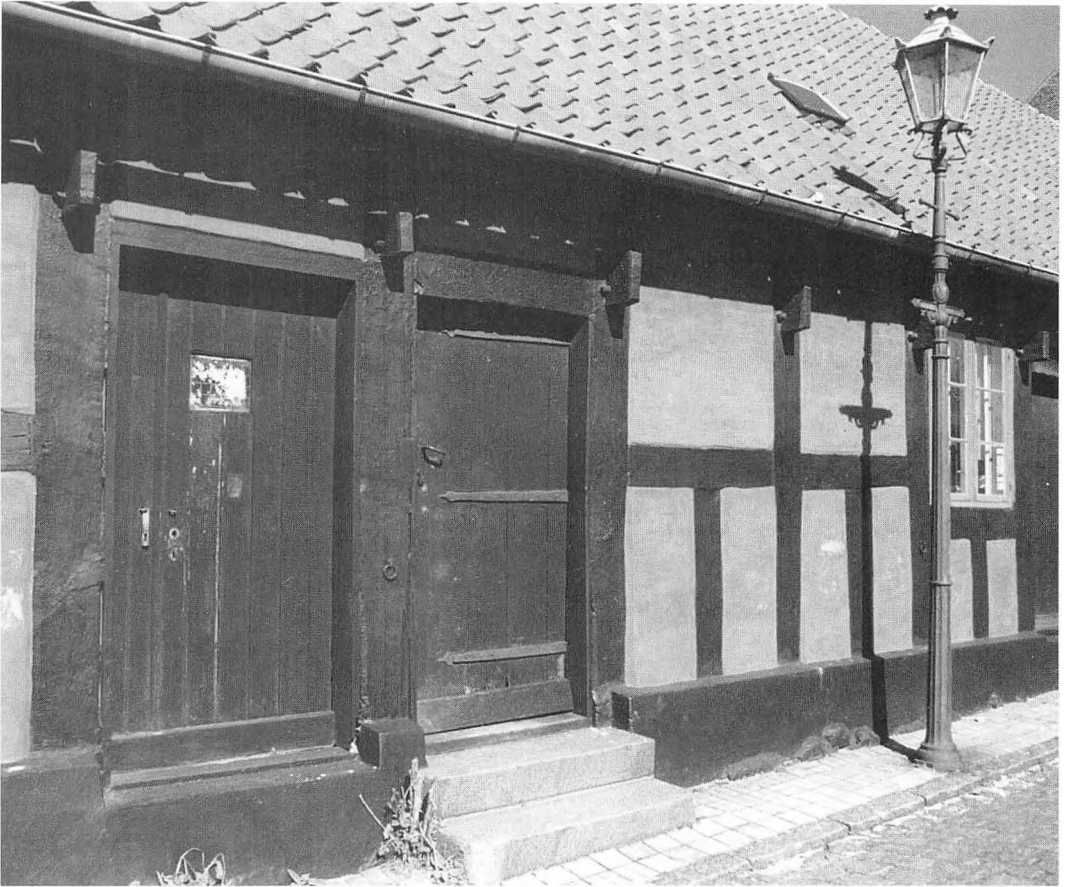
Fig. 27. Genbrug er ingen nymodens opfindelse. De svære plankedøre i Rønnes ældste toldbod, der opførtes 1684 ved havnen til afløsning af Hammershus, antages ligesom dele af husets tømmer at være hentet netop på det sløjfede slot. Foto: Thomas Eske Rasmussen.
