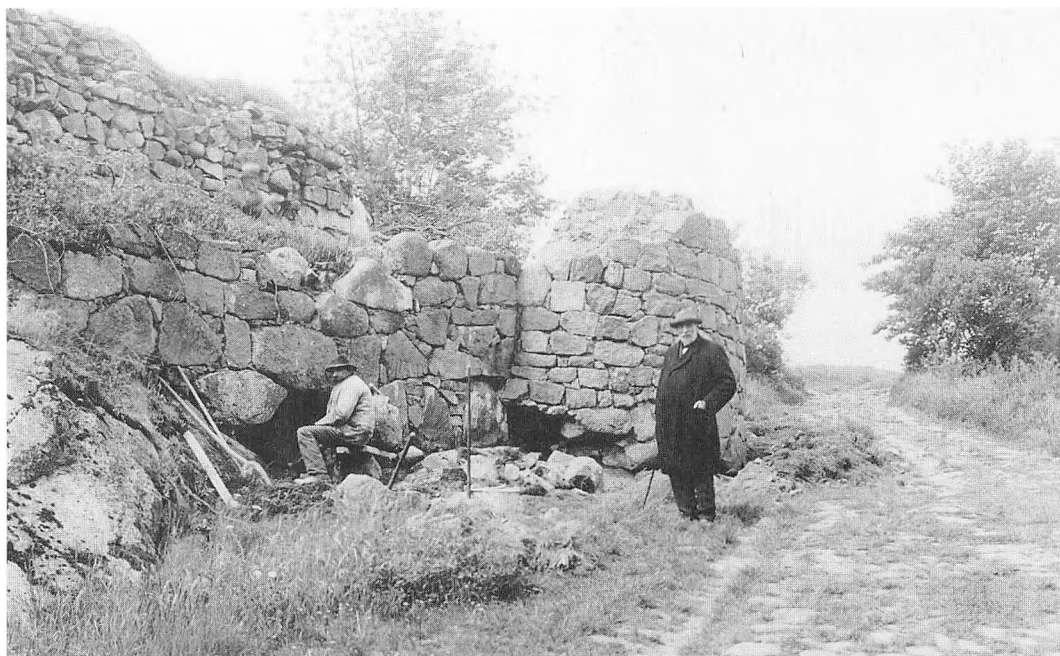
Fig. 2. Peter Hauberg inspicerer restaureringsarbejdet på muren foran tinghuset, omk. 1896. Foto: Nationalmuseet.
