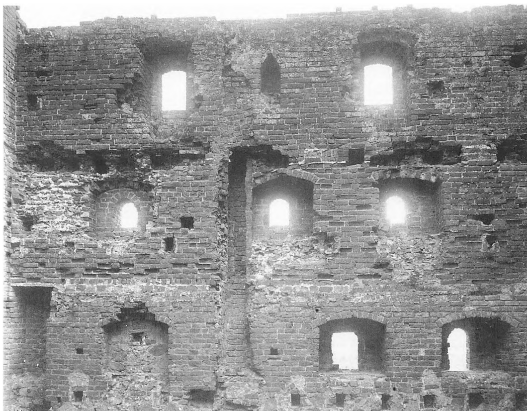
Fig. 2. Manteltårnets indvendige sydside, 4., 5. og 6. stokværk. Billedet er taget inden istandsættelsen af murværket. Sammenhold billedet med opmålingen fig. 3. Foto: P. Hauberg, 1914. Nationalmuseet.
