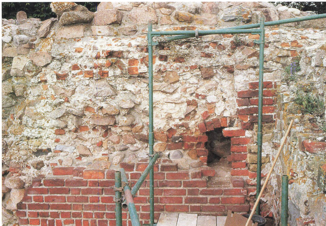
Fig. 9. Vestre ringmur. I forbindelse med vedligeholdelsesarbejdet var det muligt at registrere murens oprindelige udseende, og hvordan den var blevet forstærket ad mindst to gange. Se fig. 10. Foto: KBV.
