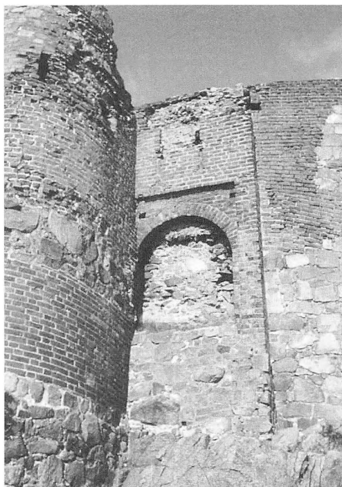
Fig. 11. Havporten, et af de store mysterier på Hammershus. Beliggende 4 m over terræn ud til de stejle klipper ned mod havet. Den kan have været en udfaldsport eller måske den oprindelige adgang til borgens, som hurtigt er blevet for besværlig. Foto: KBV.
