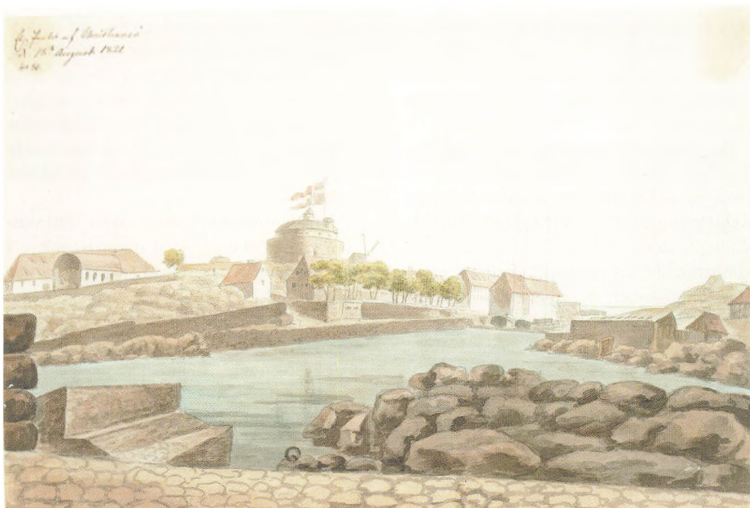
"Et Partie af Christiansö. d. 18. August 1821. No. 86". Til højre for midten i billedet kan man se de "nye" soldaterboliger, der blev bygget sidst i 1700-tallet. (Det kongelige Bibliotek. Billedsamlingen. Rawerts maleriske Reise V, 57. Accessionsnr. 1946 Nr. 239).
