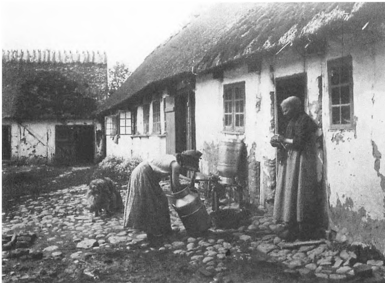
Gård i Eskildstrup, Vig s. Bemærk de lodrette stolper i hvis øverste del bjælkehovederne stikker frem. Den skrå planke i baggrunden er sandsynligvis en reparation. Fotograf Bay, Asnæs, 1920'erne.
