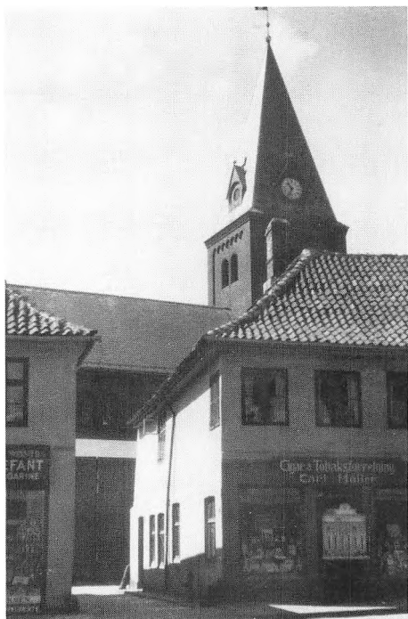
Fig. 3. I den store ejendom, Bredegade 4, hvor af vi her ser en del til højre i billedet, voksede kammerrådens mor op. Ejendommen eksisterer ikke mere. Foto: H.J.O. Minuth. Lokalhistorisk Arkiv for Aalborg kommune.
