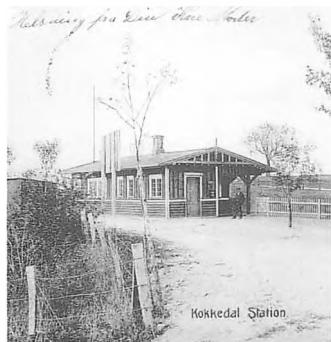
Fig. 15: Den første stationsbygning ved Kokkedal. Efter postkort 1909.
