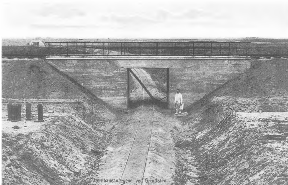
Billede fra 1915, som viser jernbanen ført hen over mergelsporet. Den nærmeste viadukt er der stadig og kan ses fra Sdr. Omme vejen, hvorfra dette billede er taget.
