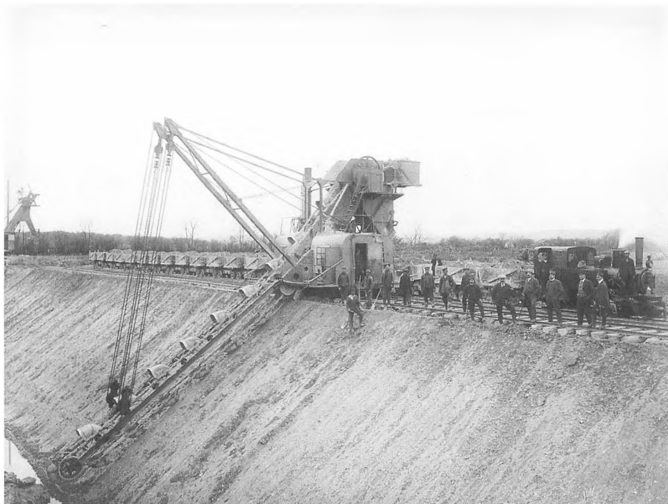
Københoved Mergelleje, 1912. Lejet ligger syd for Kongeåen og derfor syd for grænsen på daværende tidspunkt. Lejet blev dog undersøgt for Vejen og Omegns Mergelselskab. Vogntoget er ikke de normale tipvogne, men i stedet de noget større vogne, som benyttedes på de smalsporede sønderjyske amtsbaner.
