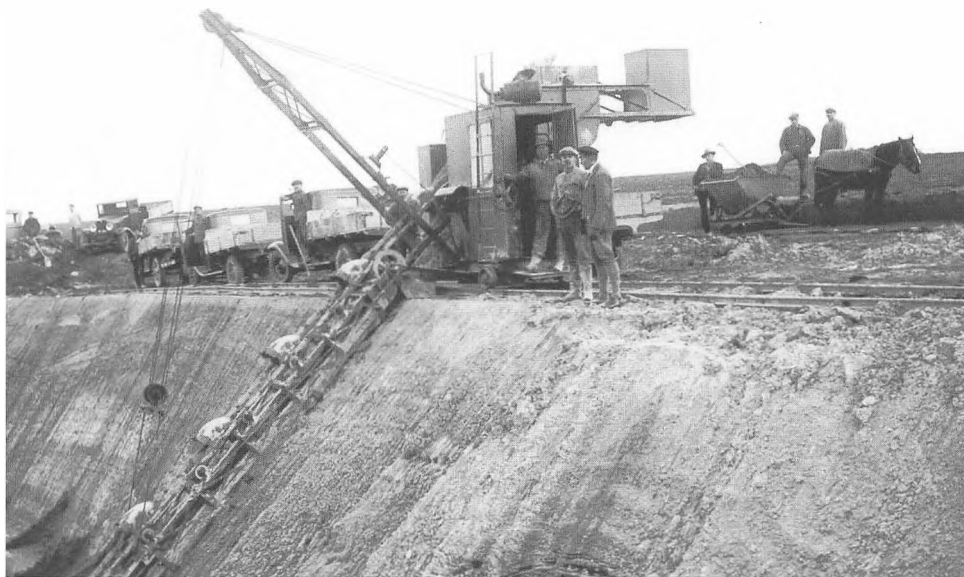
Drammelstrup Mergelleje ved Allingåbro, 1930. Et tillæg til mergelloven tillod, at også kørsel med lastbil kunne komme ind under loven. Det kom små selskaber tilgode. På billedet ses en lille gravemaskine, som lægger direkte i lastbil. Den hestetrukne tipvogn fjerner overjord.
