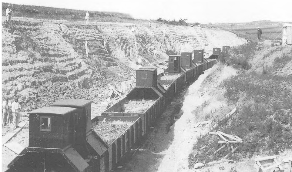
Kølsen Mergelleje 1908, året efter, at udkørslen på Alheden er startet. Straffefanger læser mergel i jernbanevogne.
