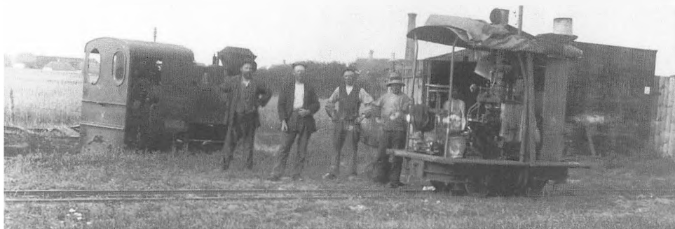
Det mærkelige køretøj i forgrunden er sikkert en af de første motorlokomotiver, drevet af en encylindret bådmotor.
