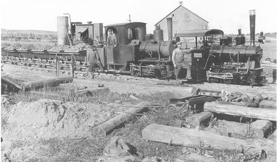
Med billedet oplyses – Gratehede, 2 stk. O og K med patentstyring. – Gratehede Mergelbane, beliggende mellem Thorning og Engesvang, udkørte 107.560 m 3 mergel i perioden 1909-15.
