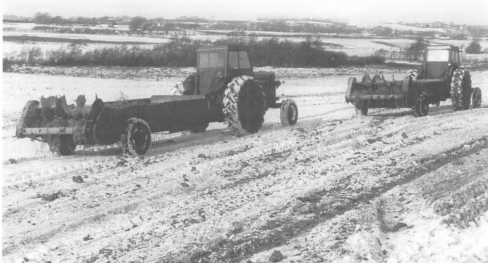
Mergelspredning med »staldgødningsspreder« ved Vindt Mølle syd for Viborg, 1965.
