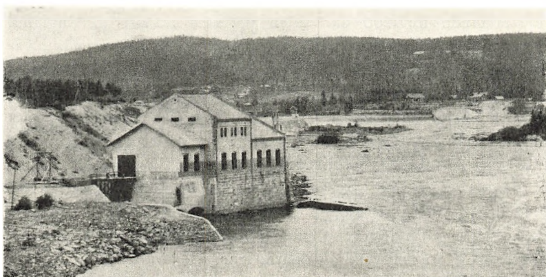
Elverum Elektricitetsverks kraftstation.
