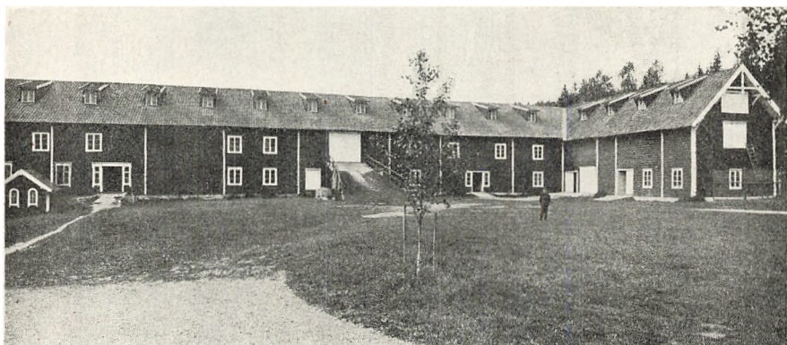
Lade, fjøs og stald paa Østerhaug. Den største udhusbygning i Elverum.
