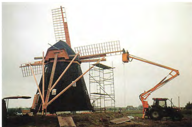
Kranen må tage det tungeste arbejde med vinger og hat. Foto udlånt af klitplantør Henrik Schjødt Kristensen
