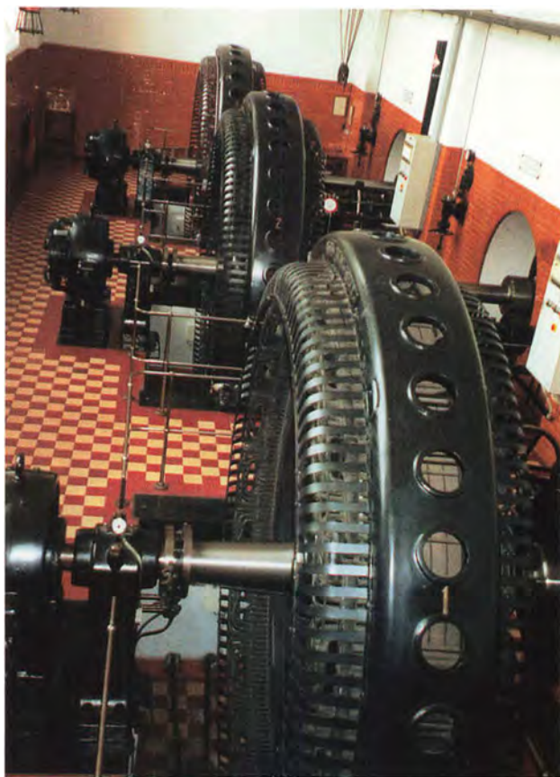
De tre stadig aktive generatorer fra Titan i Gudenåcentralens maskinhal
