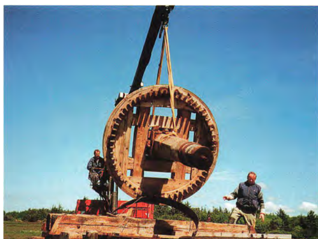
Kranen løfter mølleaksel. Foto udlånt af klitplantør Henrik Schjødt Kristensen
