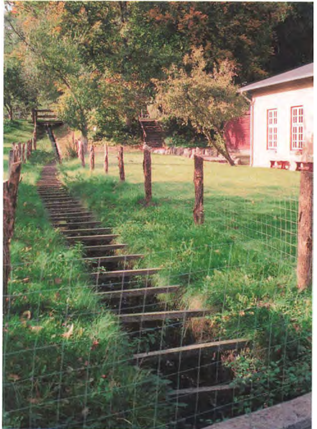
Underjordisk kanal fra det tidligere fabriksanlæg fungerer som fiskepassage ved Christiansdal Elværk
