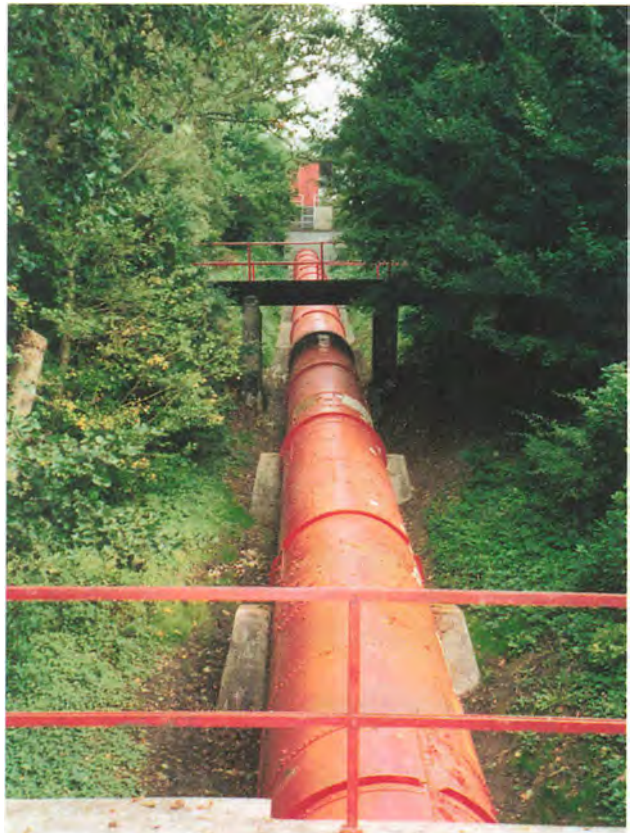
Det 80 meter lange trykrør ved Harteværket.
