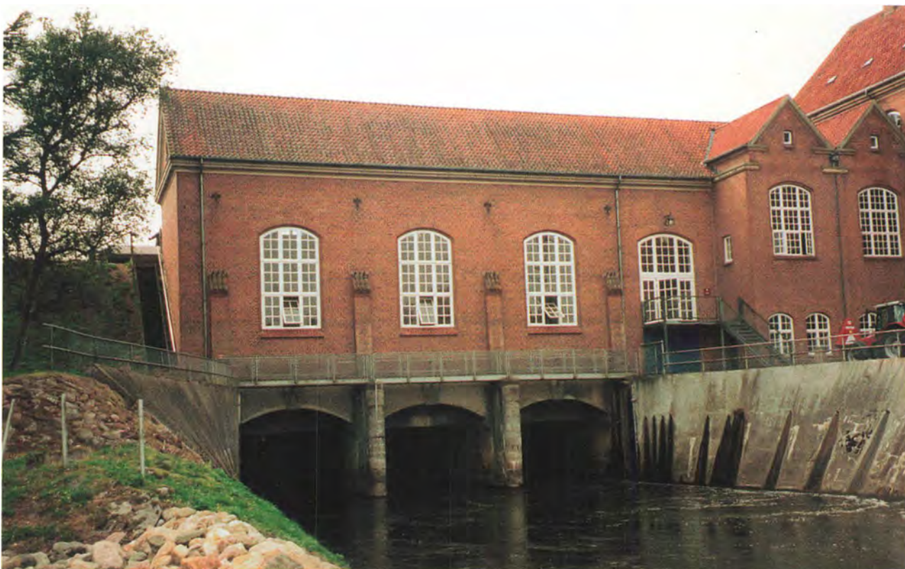
Gudenåcentralens maskinhal med de tre turbineporte
