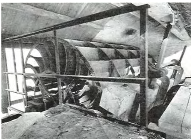
Ponceletsk underfaldshjul set fra opstrøms side. Den ene side af huset er fjernet for reparation.
