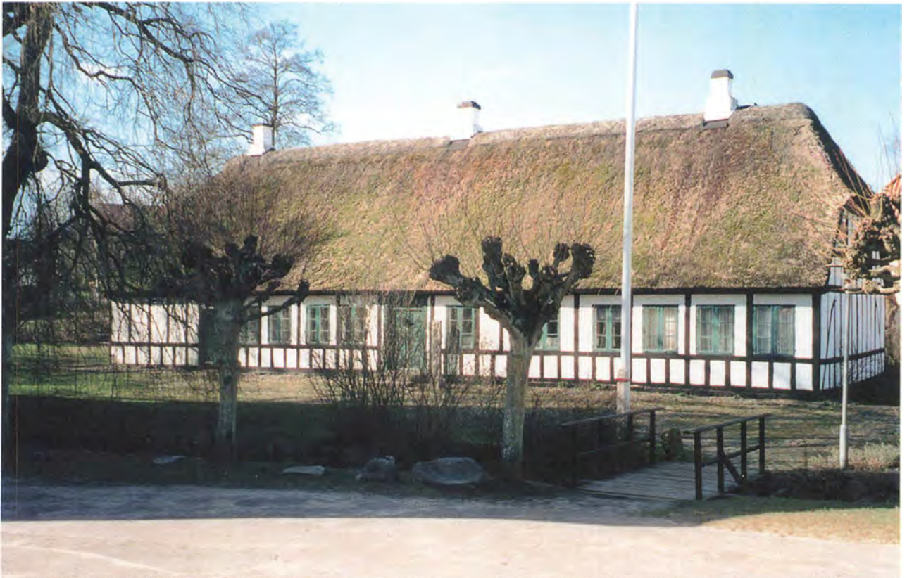
Stuehuset ved Odder Vand- og Dampmølle
