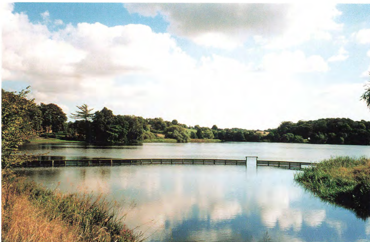
Vandkraftsøen ved Vestbirk Kraftværk
