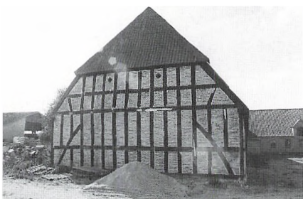
Gavlene på Søndervangs lade (ukalkede Flensborgsten i tavlene) og Andkærladen (hvidkalkede tavle) ligner hinanden. Dog er Søndervangs tag halvvalmet hvorimod Andkærladen har en spidsgavl.
