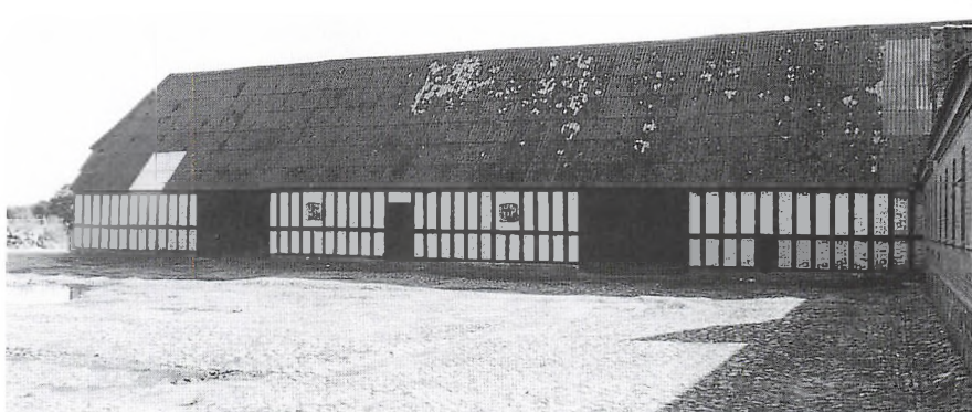
Søndervangs ladebygning set fra gårdspladsen.
