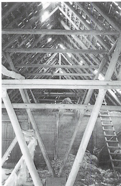
Stritsulerne forstærkede tagkonstruktionen, så tegltaget kunne bæres oppe.
