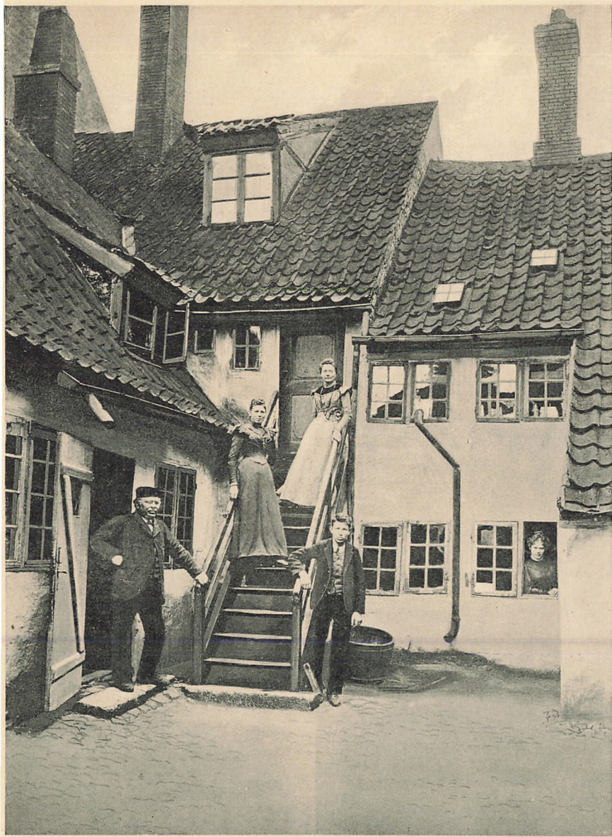
No. 26. Bagside af Algade No. 3 (brændt 1903)
