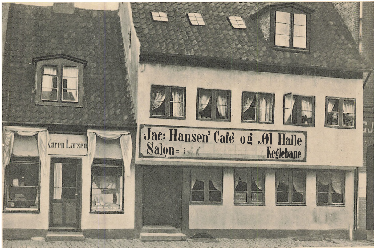
No. 34. Algade No. 3, brændt 1903.
