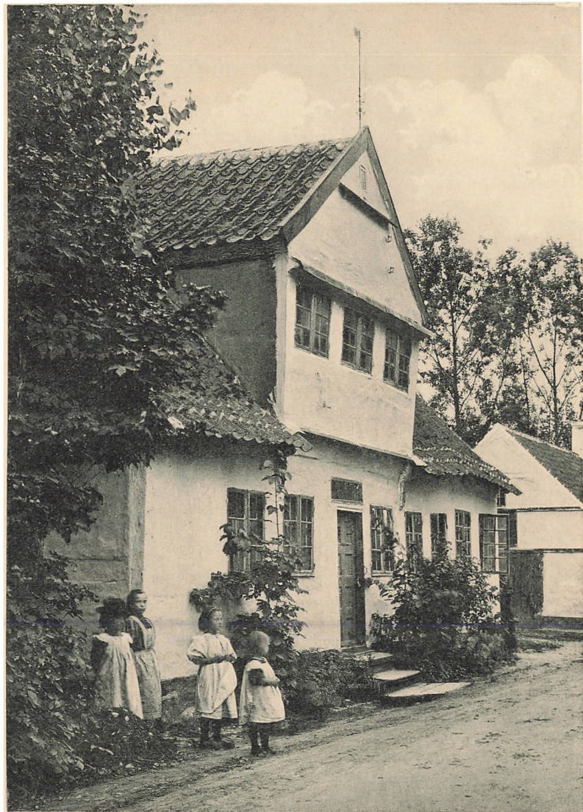
No. 27. "Kildehuset" overfor Hellig Kors Kilde, opført 1740, nedrevet 1920.
