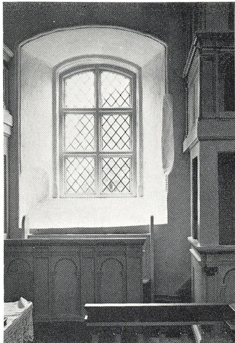
Nordøstre kirkevindue med kantrille. Desuden udhugning i murværket af hensyn til opgangen til prædikestolen.
