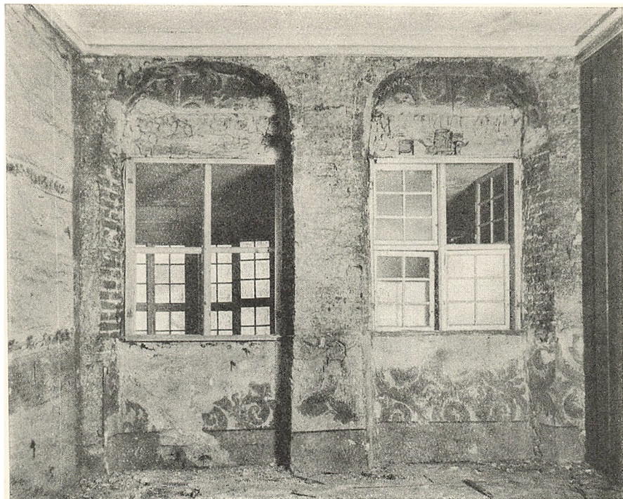
Fig. 33. Gaardværelset i 2' Stokværk 1910. De senbarokke Paneler er fjernet og den oprindelige Vinduesvæg med kalkmalede Dekorationer er kommet til Syne.
