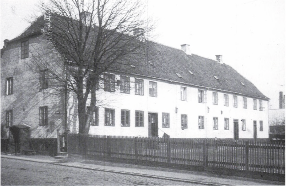
Cikoriefabrikken "Fortuna" eksisterede kun i seks år, men bygningen på Holmen forblev en karakteristisk del af bybilledet indtil 1950'erne.
