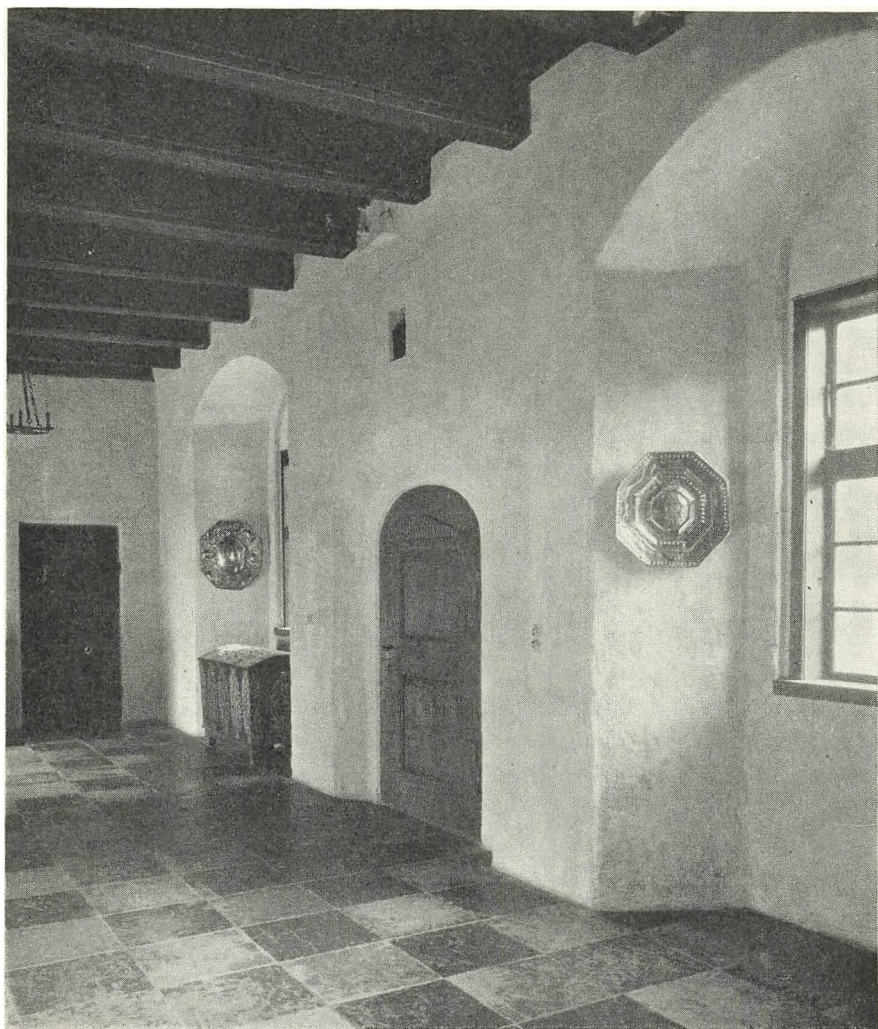
Stengang paa Broholm (Østfyn) belagt med Ølandsfliser. Døren tilhøjre fører ud til Trappetaarnet. Loftet er af svære Bjælker. Vinduessmigene viser den store Murtykkelse. I Vinduesnichen ses en Klædekiste. Bygningen opførtes 1642. Fot.: Nationalmuseet.
