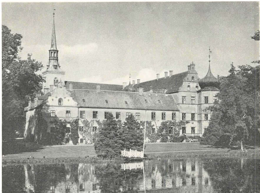
Brahetrolleborg ved Faaborg, er et Eksempel paa en Gaard med en indviklet Bygningshistorie. Den ærværdige Grundstamme i Bygningen er et middelalderligt Cistercienserkloster, som gennem Tiden er blevet ombygget, ændret i skiftende Tiders Smag. Kirken er dog stadig den fjerde Fløj i Gaarden. Det Ydre præges nu i høj Grad af en »Restaurering«, foretaget i sidste Halvdel af 1800-Tallet. Fot.: Nationalmuseet.
