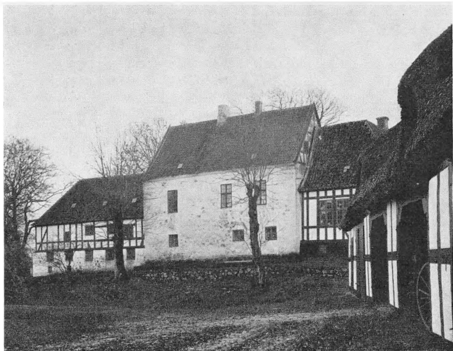
Ostrupgaard, ved Faaborg, er et af vort lands mest stemningsfulde herregårdsanlæg, bestående af et senmiddelalderligt stenhus omgivet af bindingsværkslænger fra det 18. årh. For at sikre dette enestående anlæg, der blev udstykket ved lensafløsningen, har Det serlige Bygningssyn gjort en meget stor indsats. Fot.: K. Uldall.
