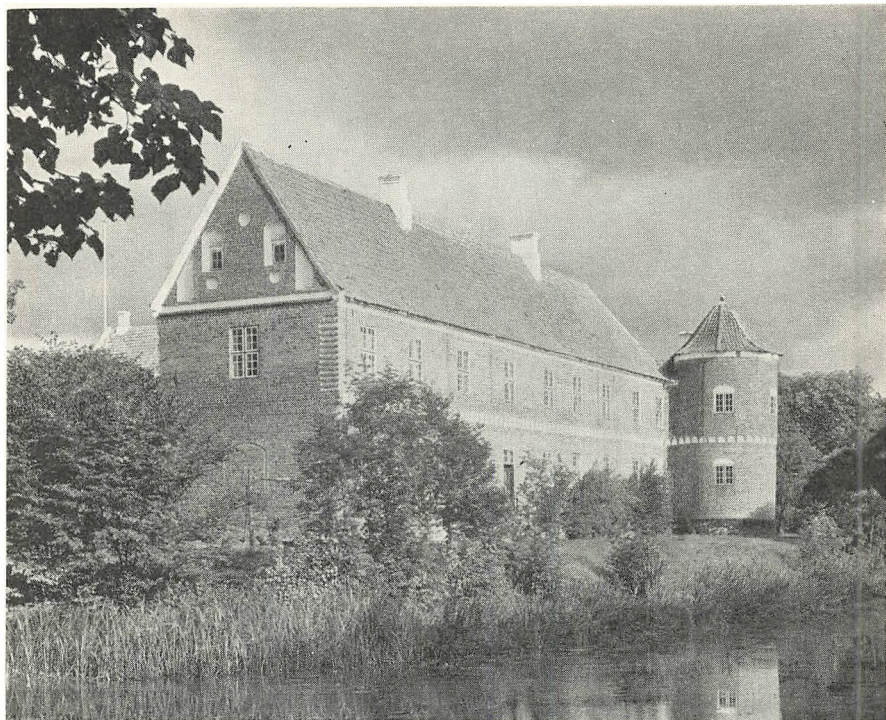
Løvenholm øst for Randers, er bygget i flere Omgange. Her ses Sydfløjen, opf. i Begyndelsen af 1600-Aarene som en Tilbygning til en noget ældre Østfløj, der anes i Baggrunden. Sydfløjen har fra Østfløjen laant Rundbuefrisen, der skiller Facadens to Stokværk, og som ved Fløjens Opførelse allerede var et gammeldags arkitektonisk Træk. Denne Frise er ogsaa ført rundt om det i 1642 byggede Hjørnetaarn. Fot.: Nationalmuseet.
