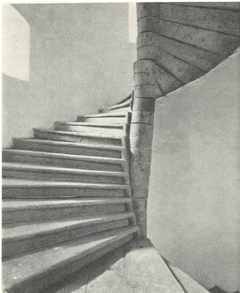
Trappetaarn med Vindeltrappe af Eg fra Slutningen af 16. Aarh. Højresnoet, saaledes at Forsvareren fra oven fik Slagrum med højre Haand, medens Angriberen hængtes af Midtstolpen. Rygaard paa Østfyn. Fot.: Nationalmuseet.
