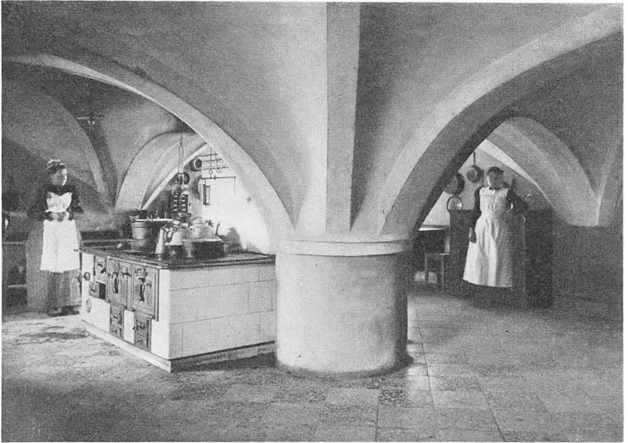
Køkken i hvælvet Kælder paa Hesselager (Østfyn), fotograferet i Slutningen af 19. Aarh. Den oprindelige Ildbænk er erstattet af et Kofjur, beklædt med hvide Fliser. Paa Væggen er ophængt Kobbertøj. Saadanne Kælderkøkkener var almindelige i Renaissancens Herregaarde. Fot.: Nationalmuseet.
