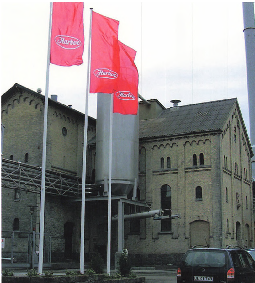
Fig. 1. Bryggeriets gamle og nyes bygninger ligger side om side på bryggeriets store areal. Det ældste bryghus på 4 etager samt de øvrige gamle produktionsbygninger er muret i gule sten med smukke udsmykninger af facaderne og med tag af brun og rød tegl. Ud mod vandet findes kontorlokaler indrettet i den tidligere direktørbolig.
